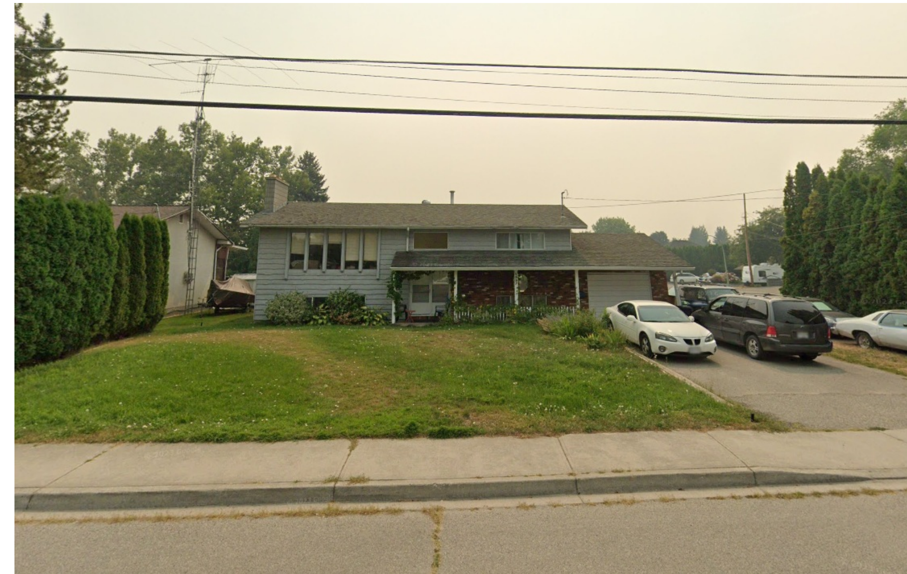
STREETVIEW NORTH (LANFRANCO RD)
